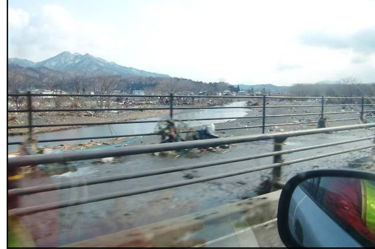
津軽石地区（津波が川を遡上し、氾濫）
